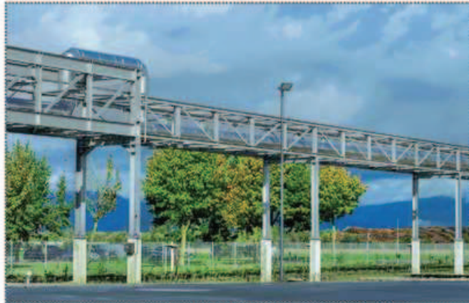
Über eine Rohrbrücke gelangt der Dampf über das Gelände der Molkerei zum Technikhaus.
